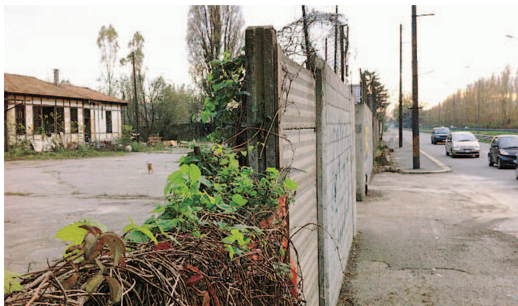
L'area del quartiere Basmetto che dovrebbe essere destinata alla Protezione civile
